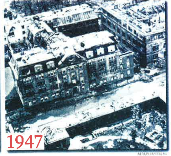
Kriegsspuren: Im Zweiten Weltkrieg wird das Gebäude schwer beschädigt.
