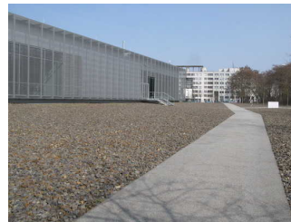
Rundgang Außengelände (neu aphaltiert)
