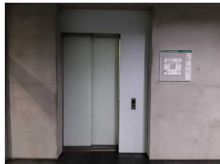
Aufzug ins Untergeschoß
