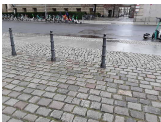
Weg zwischen Parkplatz und (Außen-)Eingang Niederkirchnerstr. 8 (Außengelände)
