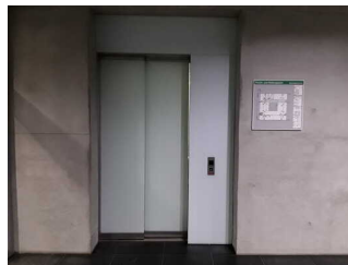
Aufzug ins Untergeschoß
