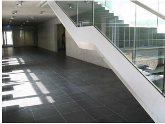
Flur im Untergeschoss
