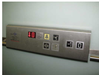
Aufzug ins Untergeschoß
