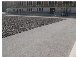
Rundgang Außengelände (neu aphaltiert)
