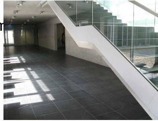
Treppenhaus im Dokumentationszentrum
