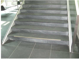
Treppenhaus im Dokumentationszentrum
