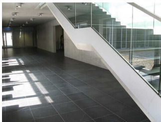
Flur im Untergeschoss
