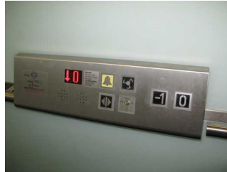
Aufzug ins Untergeschoß
