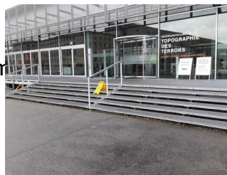
Treppe im Eingangsbereich Dokumentationszentrum (Innenausstellung)
