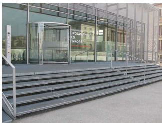
Treppe im Eingangsbereich Dokumentationszentrum (Innenausstellung)
