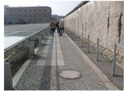
Abb.32: Außenweg „Berliner Mauer“
