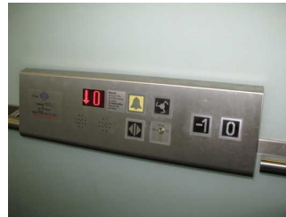
Aufzug ins Untergeschoß
