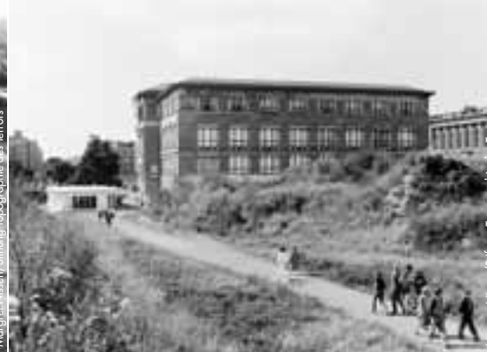
Pavillon d'exposition aménagé sur le site, 1987
