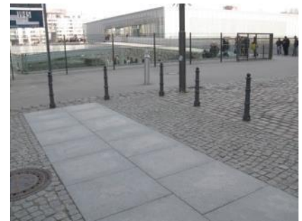
Abb. 4: Eingangsbereich Niederkirchnerstr. (außen)
