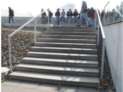
Abb. 26: Treppe zum Ausstellungsgraben
